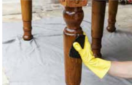
2. Nach dem Ölen den Tisch mit einem Schleifvlies abreiben. Das Vlies im Anschluss gut durchtrocknen lassen. Den Vorgang des Abreibens mit dem Hartwachsöl getränkten Schleifvlies wiederholen. Das ergibt eine strapazierfähige Oberfläche mit seidigem Glanz.
