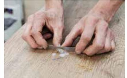
3. Fachleute arbeiten in solchen Fällen mit einer Zieh Klinge: Mit dem Metallgerät lässt sich das Wachs abziehen. Hier behelfen wir uns mit der Klinge eines Cuttermessers.
