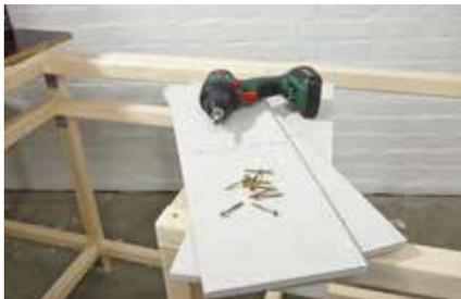
**13.** Die Gipsfaserplatten ins Format bringen. Entweder einritzen und brechen oder sägen.
