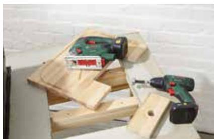
**28.** Das optionale Schneidebrett liegt auf zwei unten angeschraubten Hölzern auf – so aufgedoppelt, dass das Brett bündig mit der Arbeitsplatte abschließt.
