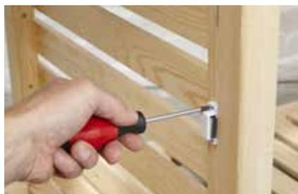
**26.** Ein aufgeschraubter Magnetschließer fixiert die Türen im geschlossenen Zustand.
