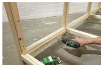
**18.** Die Auflagehölzer vorbohren und anschrauben (Schrauben 4x50).
