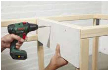
**14.** Die Platten an die Konstruktion anschrauben (Schrauben 4x50).
