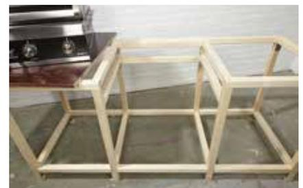
**12.** Blick auf die Unterkonstruktion aus Rahmenhölzern rund um den Einbaugrill.
