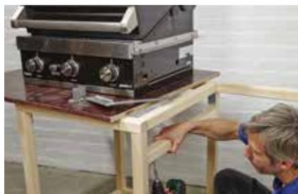
**11.** Rund um den Grill werden feuerfeste Gipsfaserplatten (etwa „Fermacell Firepanel“) angebracht. Hier wird die Unterkonstruktion dafür montiert.
