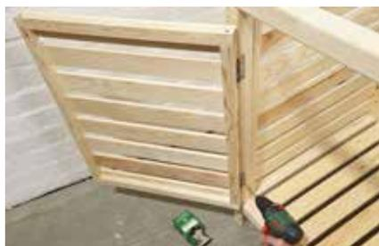
**25.** Die Türen mit Scharnieren an den Korpus montieren.
