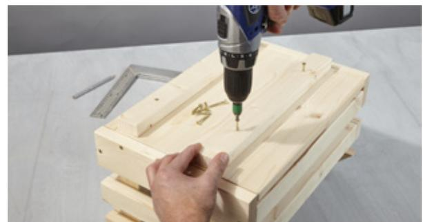
An den oberen beiden Kisten werden unten je zwei Hölzer angebracht, die dafür sorgen, dass die Kisten beim Stapeln „einrasten“.
