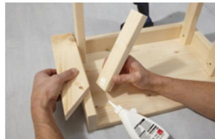
**12.** Die vertikalen Hölzer mit etwas Leimzugabe anschrauben. Die vorderen Hölzer so weit nach hinten einrücken, dass die vertikale Leiste später nicht die Schräge der obersten Leiste überragt.
