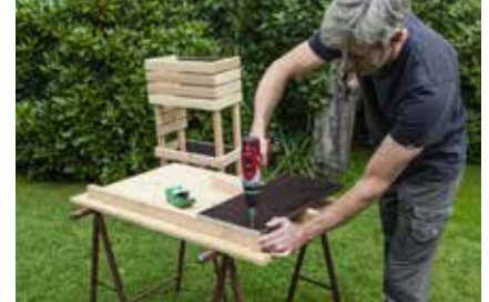
21. Das mittlere Element: Die Rückwand an die 842mm hohe Douglasienleiste schrauben.
