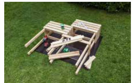
24. Nach demselben Prinzip entstehen jetzt alle weiteren Pflanzkästen.
