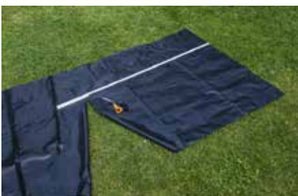
25. Die Kästen werden mit Teichfolie ausgeschlagen. Die Folie zuschneiden.
