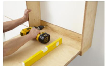
**27.** Das Möbel durch die Rahmenbretter an der Wand montieren. Die Höhe muss exakt ermittelt werden, damit die ausgeklappte Tischplatte waagrecht ist (hier: Korpusunterkante 625 mm über dem Boden).
