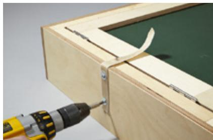
**26.** Das Gurtband mit Halbrundkopfschrauben und Unterlegscheiben anschrauben.
