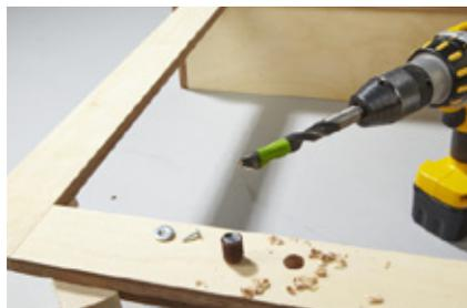
**23.** Ein Magnetverschluss sorgt dafür, dass das Bein-Element im hochgeklappten Zustand in Position bleibt. Magnetverschluss unten in die Querstrebe einbohren, dazu den passenden Bohrer verwenden (hier: 14 mm).
