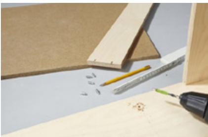
**13.** Die Position der Fachbodenträger auf die Seitenteile des Korpus übertragen und einbohren.
