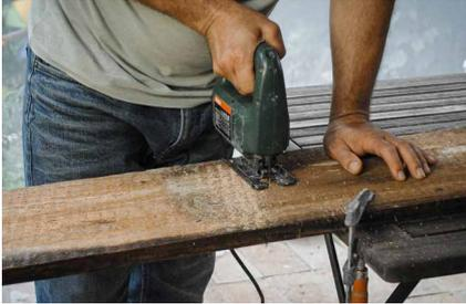
**1.** Eine 30 mm starke Holzdiele oder ein altes Brett wird zum Körper. Auf eine Länge von etwa 40 bis 45 cm absägen. Für die Schulterpartie das Brett oben nach Augenmaß abrunden. Kanten mit Holzfeile und Schleifpapier bearbeiten und brechen.
