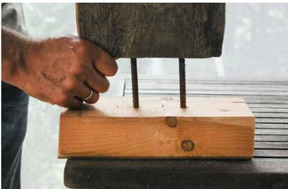
**4.** Der Sockel muss so schwer und breit sein, dass er genügend Stand bietet (hier 80x100 mm). Er wird auf eine Länge von etwa 210 mm gesägt und ebenfalls vorgebohrt. Körper und Sockel mit den Stäben verbinden, ebenso Kopf und Körper.
