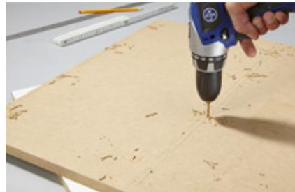
**8.** Die Verbindung von Sitzplatte und Sitzkorpusrippen vorbereiten: Die Lage der Rippen anzeichnen und mit einem 3-mm-Bohrer vorbohren.
