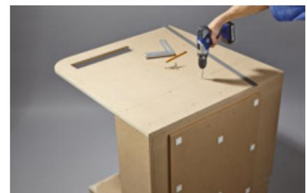
**30.** Die Seitenlehne ebenfalls anschrauben. Die Lage von Rückenlehne und Sitzkorpus anzeichnen und mit 3,5x50 mm-Schrauben verbinden.
