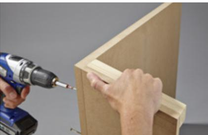
**10.** Die Sitzflächenplatte mit den Sitzkorpusrippen verschrauben (3,5x50mm-Schrauben). Behutsam schrauben, damit die Platten an den Kanten nicht aufplatzen.
