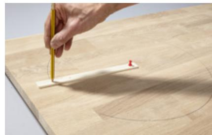
6. Mit einem Holz oder einer Schnur den Ausschnitt anzeichnen. Dessen Durchmesser richtet sich nach dem Topfdurchmesser. Er darf nicht zu groß werden, damit der Topf eine gute Auflage hat. Ggf. zusätzlich Winkel oder Holzklötzchen anbringen, die den Topf in Position halten.
