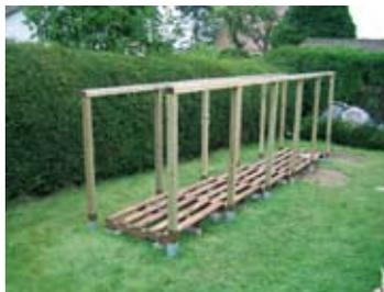
⑥ Legen Sie die waagerechten Rahmenhölzer (70 x 70 mm) auf die senkrechten Pfosten. Befestigen Sie sie mit Schwerlast-Winkelverbindern und Speed- bzw. Flachkopfschrauben.
