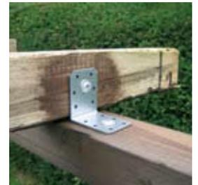
⑦ Auf der Rahmenkonstruktion befestigen Sie Dachsparren aus Kanthölzern (60 x 80 mm). Zur Fixierung verwenden Sie wiederum Schwerlast-Winkelverbinder.
