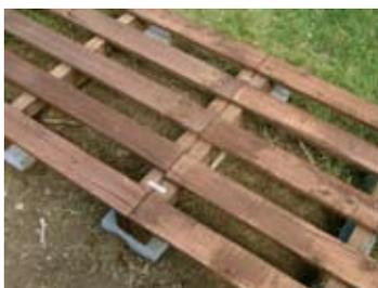
❶ Richten Sie die Europaletten auf Pflastersteinen aus. Die Steine vermeiden den Bodenkontakt des Paletten-Holzes und erleichtern eine ebene Ausrichtung des Lager-Fundaments.
