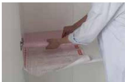
**8.** Zuerst wenig Schutzfolie entfernen, Klebefolie auflegen. Von unten langsam den Rest der Schutzfolie abziehen und mit der Rakel glatt streichen.
