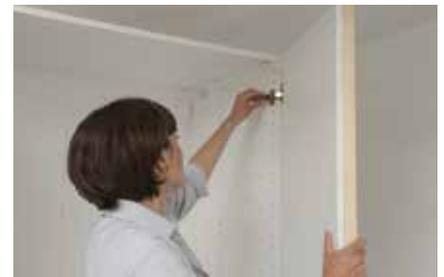
**3.** Das fertige Türblatt mit den drei Scharnieren an den vorgegebenen Stellen am Schrankkorpus befestigen.
