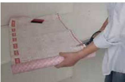
**7.** Die Klebefolie für die Regalböden zuschneiden. Mit Hilfe der Rakel wird die Klebefolie glatt und ohne Luftblasen aufgezogen.
