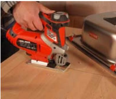
4. Mit der Stichsäge den Ausschnitt für das Becken der Spüle aussägen. Eckpunkte des Ausschnitts mit Bohrungen (Ø 8 mm) markieren.
