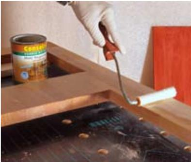
19. Anschließend alle Flächen mit einem Lackroller lackieren. Mit Körnung 320 zwischenschleifen. Nochmals lackieren.
