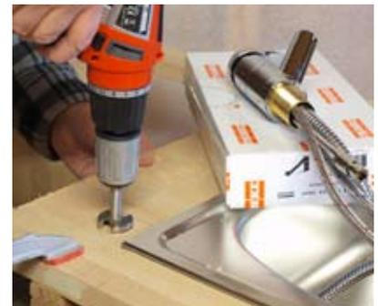
6. Mit einem Topfbohrer (Ø 35 mm) das Loch für die Armatur bohren: mit 3-mm-Bohrer vorbohren. Ein unter die Bohrung gespanntes Brett verhindert das Ausreißen des Holzes.
