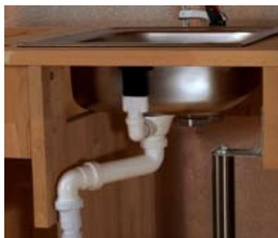
26. Aufnahme von hinten: Da unter dem Spülbecken der Rollwagen eingeschoben wird, wird ein Raumsparablauf und ein flexibles Siphonrohr verwendet.
