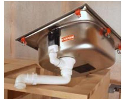
24. Vor dem Einbau des Spülbeckens werden Ablauf und Überlauf montiert.
