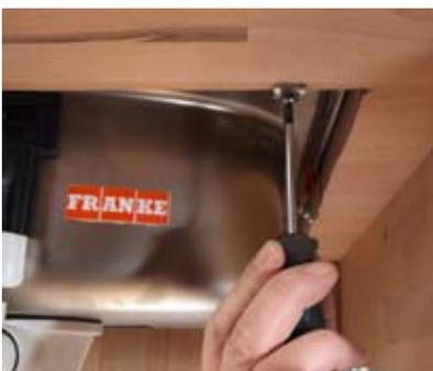
25. Das Becken wird mit Halteklammern unter der Abdeckplatte fixiert.
