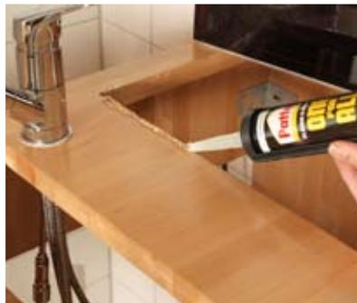
23. Das Kochfeld wird eingesetzt. Es wird mit den mitgelieferten Klammern an die Abdeckplatte montiert. Zusätzlich kann es mit einem Allzweckdichtkleber fixiert werden.
