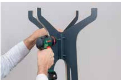
**5.** Wenn die Farbe getrocknet ist, die vier Garderobenstücke mit den Leistenteilern zusammenschrauben (Holzschrauben, 4 x 40 mm). Das breitere Garderobenteil füllt dabei die Mitte aus (siehe auch Seite 2). Die langen Leisten (190 mm) am Fuß der Garderobe anbringen und die kurzen Leisten (140 mm) oben. Zum Schluss noch die Knäufe mit den Gewindestangen durch die dafür vorgesehenen Löcher an die Garderobe schrauben. Fertig ist die schicke Garderobe für den Flur!
