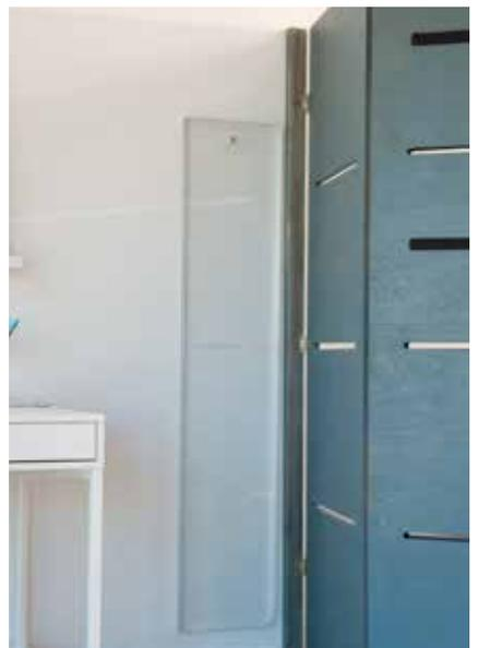
Die Wandbefestigung: Eine Theaterlatte wird an die Wand geschraubt, der erste Flügel daran befestigt. Die Acrylglasböden hängen aufgeräumt an einer Schraube an der Wand.
