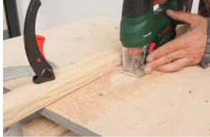
**2.** Die Schlitzte mit der Stichsäge einschneiden. Damit die Schnitte gerade werden, eine Hilfsleiste als Führungsschiene mit Zwingen fest an das Brett klemmen.
