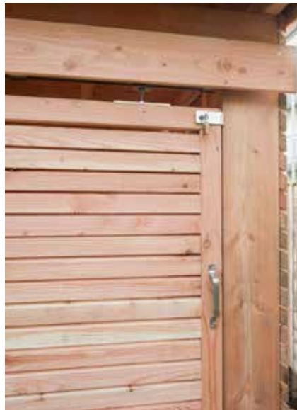
29. Die Griffe und die Sicherheits-Überfallen mit der Ösenplatte montieren. Jetzt ist der Bikeport abschließbar.
