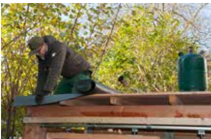
28. Die Dachabdichtung wird durch Erhitzen fest verschweißt.
