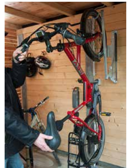
30. Zuletzt geht's an die Innenausstattung. Wir haben den Bikeport mit kräftigen Fahrradliften mit Gasdruckfeder ausgestattet, die die schweren E-Bikes tragen.
