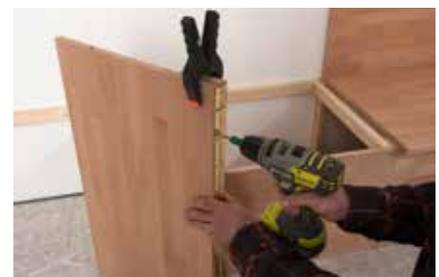
**9.** Nachdem die Klavierbänder auf Länge (800 mm) geschnitten wurden, diese an die entsprechenden Kanten der beiden Sitzflächenteile schrauben.
