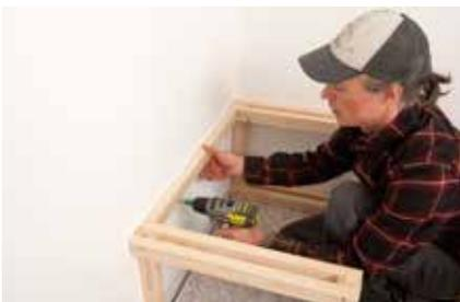
**4.** Position der Löcher auf die Wandleiste übertragen und diese anschrauben.
