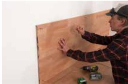
**11.** Die Befestigungsschrauben durch die Wandplatte schrauben, diese mit leichtem Schlag an die Wand drücken. So werden die Löcher an der Wand markiert.
