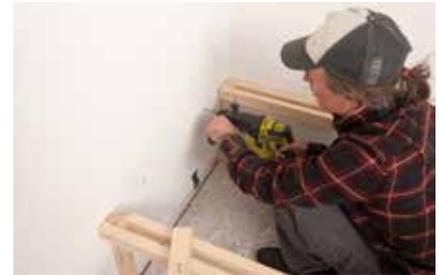
**3.** Grundgerüste aufstellen, mit der Sitz- oder Frontplatte den Abstand kontrollieren und die Gerüste anschrauben. Das Maß für die Wandleiste ermitteln, die Löcher für die Befestigung bohren und Dübel einsetzen.
