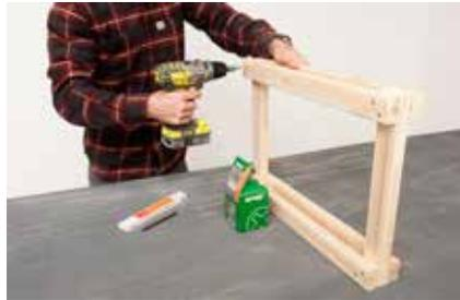
**2.** Die Grundgerüste zusammenschrauben. Die Latten an den Ecken mit jeweils zwei Schrauben befestigen. Auf Rechtwinkligkeit achten.
