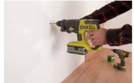
**12.** Die Löcher für die Befestigung der Rückenlehne bohren.
