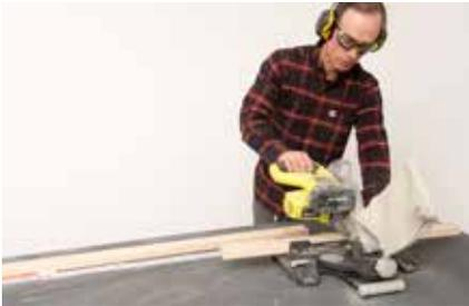
**1.** Für die Banklänge von rund drei Metern brauchen wir fünf Grundgerüste. Die Latten dafür mit der Kappsäge zuschneiden.
