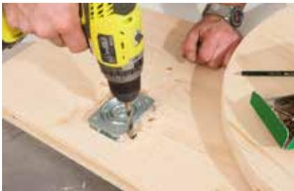
**11.** Die Abdeckplatte an den markierten Stellen durchbohren, und zwar mindestens in Größe der Schraubköpfe, damit diese durchgesteckt werden können.
