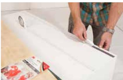
**14.** Die Abdeckplatte mit Montageband (3M) auf dem „Besta“-Element fixieren.
