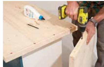
**3.** Dann mit dem Bohr-Schrauber die Gegenbohrung vornehmen.
