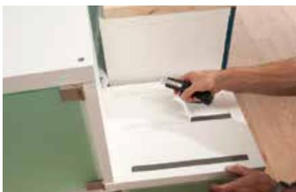
**22.** Die Schutzfolie vom Montageband abziehen und einen Regalwürfel auf das untere Regalelement kleben.
