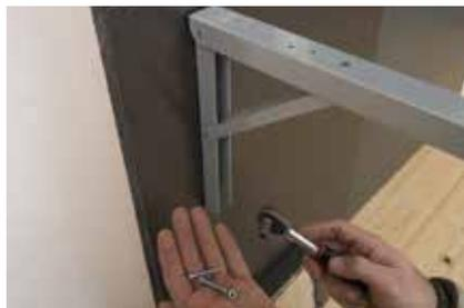
**22.** Für die Befestigung der Konsolträger ist es ratsam, Schrauben mit Muttern zu verwenden. Holzschrauben würden aufgrund der geringen Plattenstärke durch die Belastung eventuell ausbrechen.
