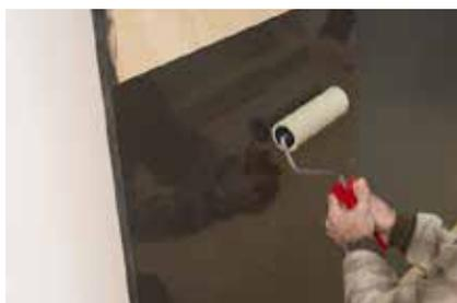
**17.** Damit eine vollflächige Haftung entsteht, die Platte von der Mitte zu den Seiten mit einem Gummiroller glatt streichen.
