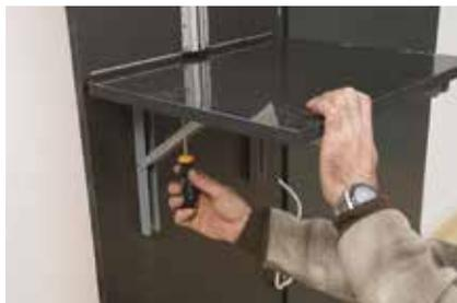
**23.** Mit jeweils drei Holzschrauben pro Träger wird das mit Effektplatten beklebte Board auf den Konsolträgern befestigt.
