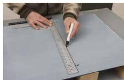
**9.** Die Acrylglasplatte ggf. auf Maß schneiden. Die Schnittlinie anzeichnen. Die Platte zum Sägen fixieren und mit einer Führungsschiene arbeiten, damit die Säge nicht verkantet.
