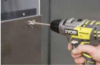
**19.** Im Abstand von 20mm zur Oberkante und 50 bzw 75mm zur Seite werden mit einem 12er-Bohrer Löcher für die Kabeldurchführungen durch die Rückwandplatte gebohrt.
