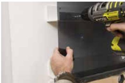
**13.** Die Schraubenlöcher vorbohren. Die Platte mit jeweils zwei Flachkopf-Holzschrauben pro Board befestigen. Achtung: mit Fingerspitzengefühl schrauben, Acrylglas bricht schnell!
