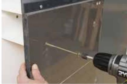
**20.** Zur zusätzlichen Fixierung der unteren Blende diese mit zwei Schrauben (hier zirka 6x140mm) direkt unter der oberen Bildleiste an der Wand befestigen.
