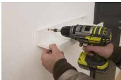
**5.** Zuerst die Leiste anbringen, an der die untere Verkleidung angeschraubt wird (siehe Maßskizze S.3). Position mit der Wasserwaage prüfen.
