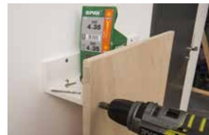
**6.** Die Frontplatte oben und unten an die Leisten schrauben. Auch hier: Löcher vorbohren und Schrauben versenken.
