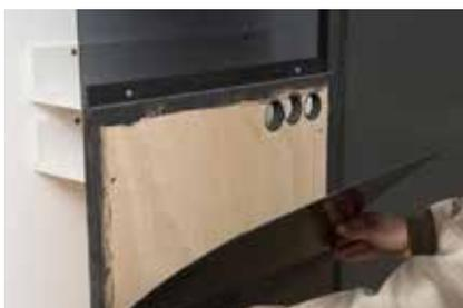
**16.** Folie von der Rückseite abziehen. Die Platte bündig mit der Unter- und einer Seitenkante ansetzen und ankleben.
