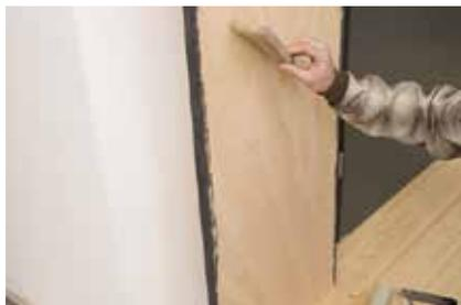
**14.** Jetzt die unteren Platten mit Effektplatten beziehen: bevor diese aufgeklebt werden, die Platte abfegen, um die Haftung zu gewährleisten.
