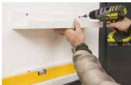
**8.** Nun die restlichen Leisten entsprechend der Maßskizze exakt übereinander anbringen und mit der Wasserwaage kontrollieren.
