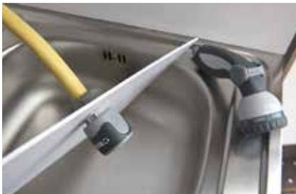
**35.** Ein Gartenschlauch wird als Wasserleitung verwendet, eine Gartenspritze als Wasserhahn. Dafür in die Rückwand ca. 20 cm über dem Spülbecken ein Loch sägen oder bohren (Größe richtet sich nach dem Aufsatzstück für den Gartenschlauch) und in den Spritzschutz an gleicher Stelle ein Loch schneiden.
