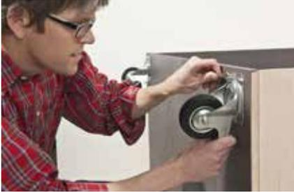
**13.** Für die Mobilität sorgen vier stabile Rollen mit Anschraubplatte, die mit Schlossschrauben angebracht werden. Löcher vorbohren.
