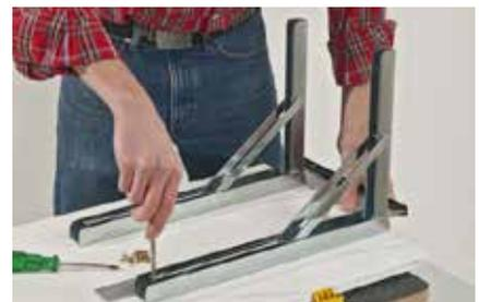
**30.** Die Klappkonsolen werden zunächst an die Tischplatten geschraubt, dann an den Rückseiten der Kubustüren befestigt.
