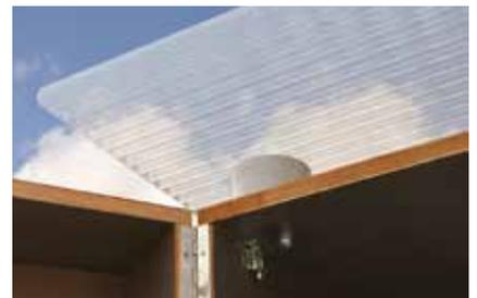
**39.** Das Dach liegt auf Distanzstücken auf und wird mit zugeschnittenen Gewindestäben und jeweils U-Scheiben und Hutmuttern von oben und unten befestigt. Überstand Dach vorn 100, hinten 50 mm.
