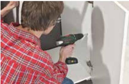
**16.** ... mit einer Schraube befestigen. Den Kühlschrank links daneben stellen und die Einheit Spüle und Ceranfeld oben aufsetzen.
