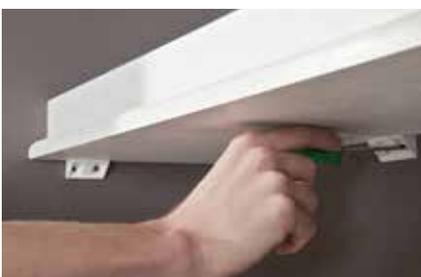
**31.** Universaleckverbinder als Bordträger anschrauben. Eine angeschraubte Stopperleiste verhindert das Herunterfallen von Gegenständen.
