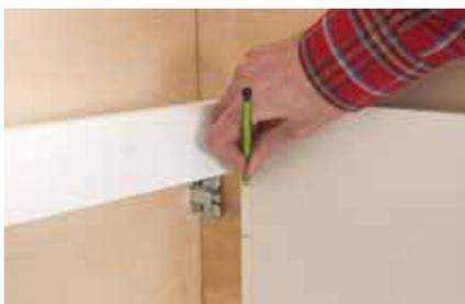
**10.** In den fertigen Kubus Unterschrank einstellen. Ausklinkung anzeichnen. Die Ausklinkungen mit der Stichsäge vornehmen.
