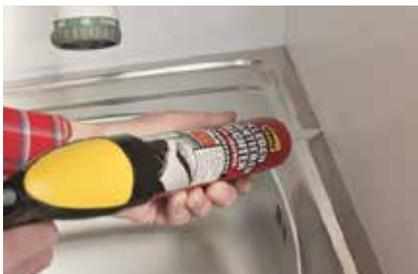
**38.** Die Fuge zwischen der Hartschaumplatte und der Kochinsel wird mit UHU „Kleben, Montieren, Dichten“ geschlossen. Das fixiert die Miniküche zusätzlich. Zum Schluss noch Doppeltorüberwurf, Kistengriffe und Haken anbringen.
