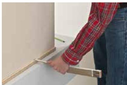
2. Montage Mittelschrank: Die Seitenwand um 1 cm eingerückt auf die Rückwand stellen, Wandstärke markieren. Innerhalb dieser Markierung Position der Dübel anzeichnen. Dübelabstand: 42,5 cm.
