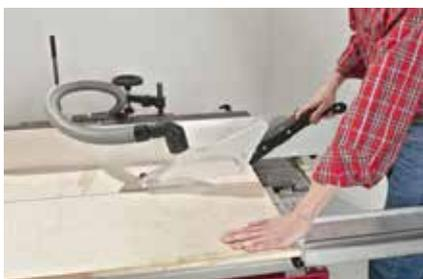
1. Alle Bauteile nach Materialliste an der Kreissäge zuschneiden oder im Baumarkt auf Maß sägen lassen.
