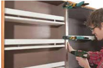
**33.** Damit die Korpustüren voll (180°) geöffnet werden können, müssen Dach- und Bodenüberstand (10 mm)
