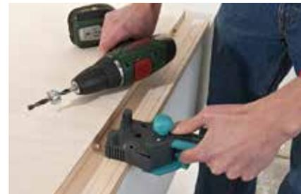
**6.** Gebohrte Platte exakt über die zu bohrende Platte legen, mit dem Meisterdübler die Gegenbohrungen vornehmen.
