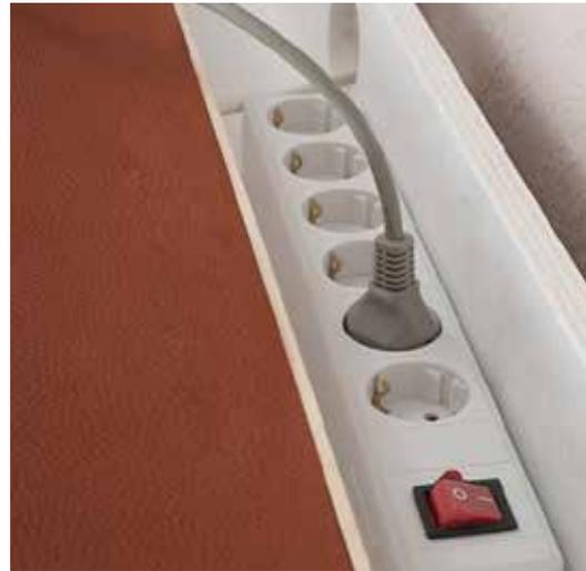
**Die Heimwerkervariante:** Wir lassen eine Mehrfachsteckerleiste in einem Kanal an der Rückseite des Schreibtischs verschwinden. Soll der Kanal im unbeutzten Zustand unsichtbar sein, einfach eine passende Abdeckplatte in Stärke der Schreibtischplatte zuschneiden. Die Platte mit einem Griffloch versehen.
