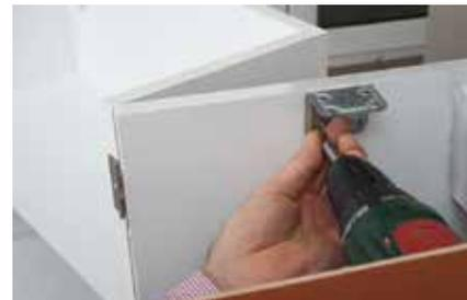
**25.** Für die Befestigung der Tischplatte an jeder Seite einen Winkel anschrauben, Tischplatte auflegen und ebenfalls anschrauben.
