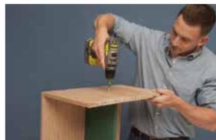
**6.** Beim Verschrauben darauf achten, dass sich die Schraubköpfe versenken, also bündig mit der Plattenoberfläche abschließen.
