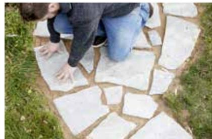
**5.** Jetzt die Natursteinplatten auf dem Sand verlegen. Zwischen den Platten stets 5 bis 10 cm Platz lassen. Wenn die Platten ausgerichtet sind, gut andrücken und mit einem Gummihammer festklopfen. Die Zwischenräume als Drainage mit dem restlichen Kies auffüllen.
