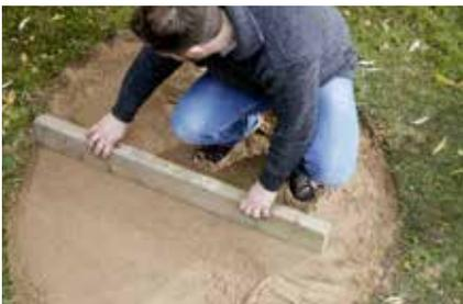
**4.** Anschließend eine Schicht Pflastersand auf dem Kies verteilen und glatt ziehen – beispielsweise mit einer Holzleiste. So liegen später alle Platten eben auf dem Boden.
