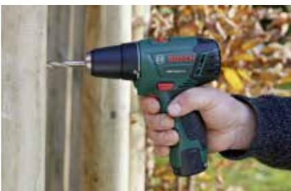
**8.** Für einen besseren Halt die Pfähle mit Zaundraht verbinden. Hierfür mit dem Akku-Bohrschrauber und einem dünnen Holzbohrer je ein Loch in das obere und untere Drittel jedes Zaunpfahls bohren. Durch beide „Lochreihen“ einen Draht ziehen: Am ersten Pfahl den Draht von außen nach innen durch das Loch fädeln, beim nächsten Pfahl von innen nach außen ziehen – bis alle Pfähle miteinander verbunden sind. Am Ende die Drahtenden fest verknoten.
