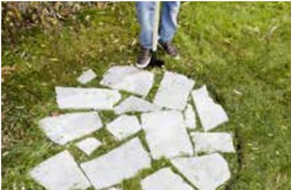
**1.** Zunächst die Maße festlegen: Mit Natursteinplatten den Boden der zukünftigen Dusche auslegen. Anschließend mit einem Spaten den Umriss rings um die Platten einstechen.
