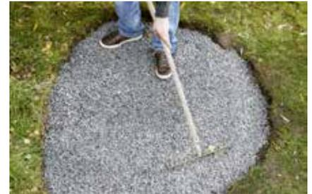
**3.** Damit der Untergrund genügend Festigkeit erhält, den Boden für die Natursteinplatten vorbereiten: Mit einem Rechen Kies gleichmäßig innerhalb der Fläche verteilen.
