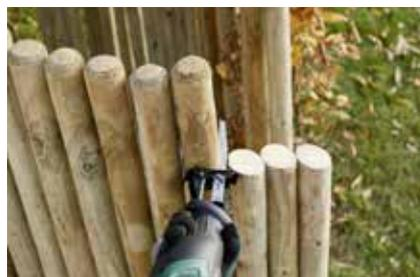
**9.** Mit Hilfe einer Säbelsäge erhält die Duschwand ihren schwungvollen Abschluss: Das obere Ende der Zaunpfähle wellenförmig kürzen. Dann die Dusche montieren: je nach Modell im Boden oder an einem Zaunpfahl befestigen.
