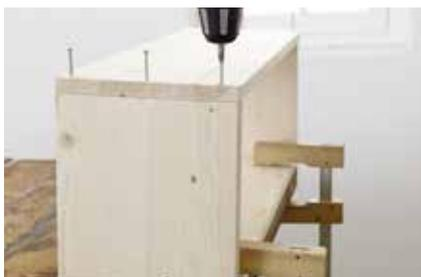
**5.** Um den Kasten zusammenzufügen, bohren Sie mit dem dünnen Holzbohrer die Löcher für die Schrauben vor. Verschrauben Sie die vier Teile dann.
