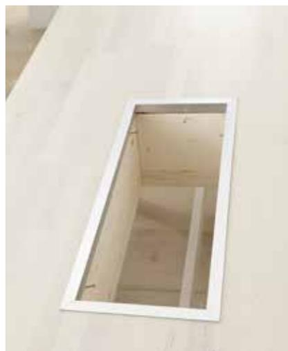
**7.** Aus dem selbstklebenden Aluwinkelprofil das Rahmenprofil an der Oberkante der Aussparung fertigen. Der Rahmen sollte im Zweifel eher zu breit als zu schmal werden.
