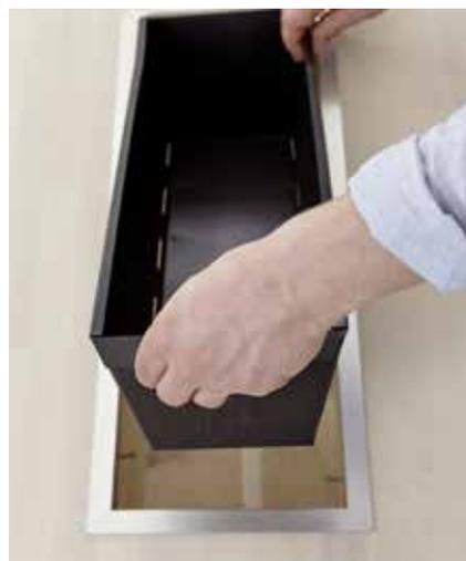
**8.** Jetzt können Sie den Grill einsetzen. Sein Rahmen liegt auf dem Aluprofil auf. Damit er nicht verrutscht, im Unterbaukasten dünne Schrauben als Abstandhalter eindrehen.
