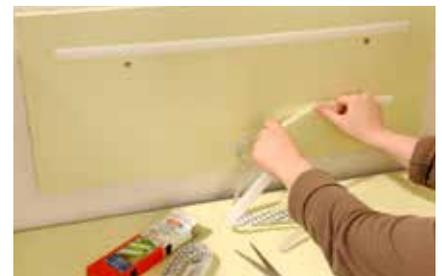
**6.** Die zugeschnittenen und lackierten Bretter für die Rückenlehnen werden über der Sitzfläche an die Wand geschraubt. Dann jeweils zwei Streifen Klettband ankleben und die Gegenstücke an die mit Stoff bezogenen Schaumstoffplatten anbringen.
