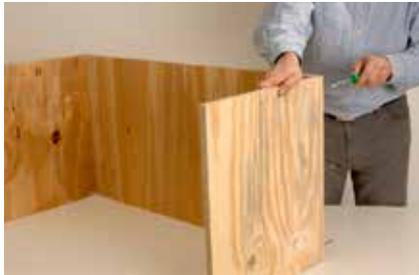
**2.** Alle Holzteile schleifen. Für die Bank zuerst die Sitzfläche auf die Wangen schrauben und dann die Mittelwand an der Sitzfläche befestigen. Alle Vorderkanten schließen bündig ab.
