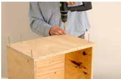
**5.** Für die Rollkästen zuerst die Front mit einem Seitenteil und der Rückwand verschrauben. Achtung: Die Front ist um 18 mm zurückversetzt. Danach den Boden einsetzen und zum Schluss das zweite Seitenteil anschrauben.
