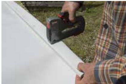
**22.** Den Markisenstoff um eine der Latten schlagen, antackern und direkt unter dem Dachüberstand an die Seitenbalken schrauben. Zuvor an der Gegenseite einen „Tunnel“ für die andere Latte nähen.
