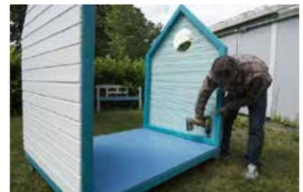
**15.** Mit mindestens vier Schrauben werden die Seiten bündig mit der Außenkante auf den Boden geschraubt.
