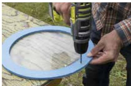
**17.** Die Acrylplatte mit Silikon auf die Innenseite des Blendrahmens kleben. Mindestens vier Schraublöcher für die Befestigung vorbohren.
