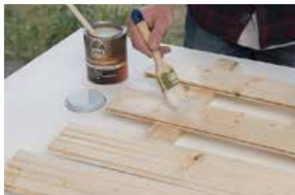
**4.** Alle weiteren Hölzer werden mit Wetterschutzfarbe gestrichen. Zuvor einen Holzschutzgrund gegen Bläue, Pilze und Insektenbefall auftragen.
