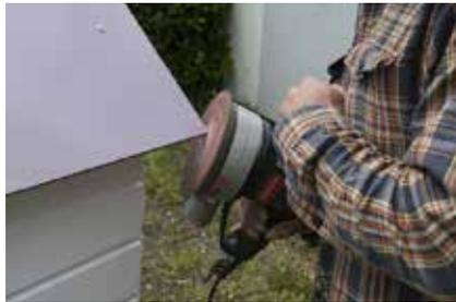
**20.** Die scharfkantigen Ecken mit dem Schleifgerät abrunden.
