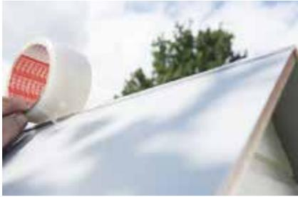
**26.** Sollte sich am First eine Fuge bilden, kann diese mit extrastarkem, transparentem Packband oder farbigem Gewebeband geschlossen werden.
