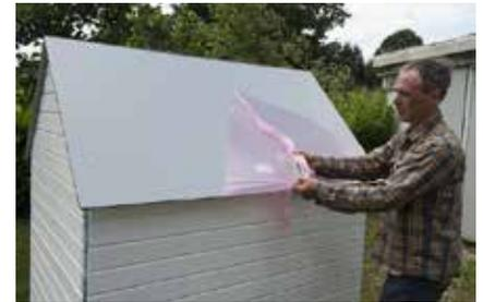
**21.** Erst nachdem die Platten angeschraubt sind, die Schutzfolie entfernen.
