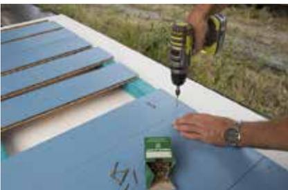
**7.** Die Unterkonstruktion für den Boden mit jeweils zwei Schrauben zusammenfügen. Darauf die Bodenbretter befestigen: entweder mit Schrauben oder unsichtbar mit dem Tacker durch die Nuten.
