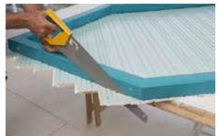
**9.** Die Bretter für den Giebel werden zunächst nur grob vorgeschnitten und dann mit einer Handsäge angepasst.
