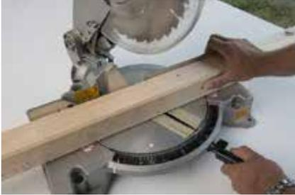
**1.** Die Beplankungsbretter und die Konstruktionsbalken mit der Kappsäge zuschneiden. Beim Zuschnitt der Konstruktionsbalken die Winkelschnitte beachten und auf der Kapp- und Gehrungssäge einstellen.
