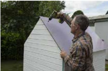
**19.** Nachdem die HPL-Platten auf beiden Seiten an zwei Stellen vorgebohrt wurden, werden sie mit Linsenkopfschrauben befestigt.
