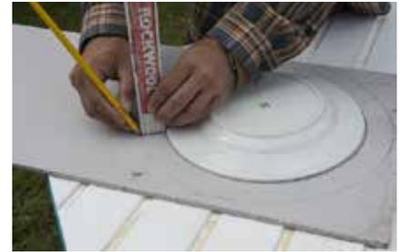
**12.** Beim Blendrahmen des Bullauges dient der zusammengefaltete Zollstock als Zeichenhilfe.
