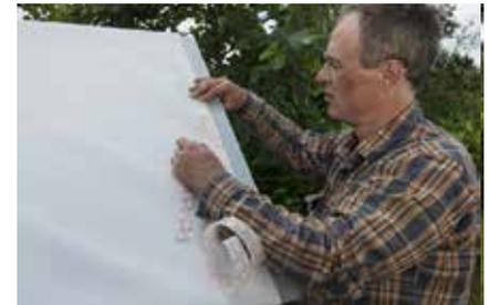
**24.** Damit die Markise im geschlossenen Zustand auch die Seiten abdichtet, wird auf beide Stoffrückseiten das Druckverschlusssystem „Dual Lock“ geklebt.
