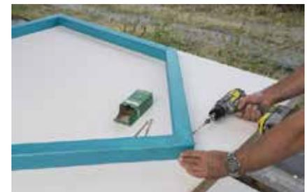
**6.** Die Konstruktionshölzer erhalten einen Schlussanstrich in Petrol. Die Grundkonstruktionen verschrauben. Immer zwei Schrauben pro Verbindung einsetzen, damit sich die Hölzer nicht verdrehen.
