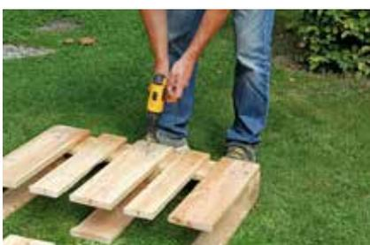
5. Für Stabilität der geschlossenen Palettenseiten sorgen Sie mit einigen zusätzlichen Schrauben.
