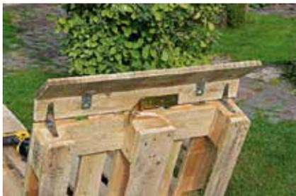
**22.** Dann die Nackenstütze fertigen: Zwei schmale Teile mit 135-Grad-Verbindern aneinander befestigen und mit Scharnieren am Sitz festschrauben. Mit dem Kistenband in der Mitte wird für die Neigung der Stütze gesorgt.
