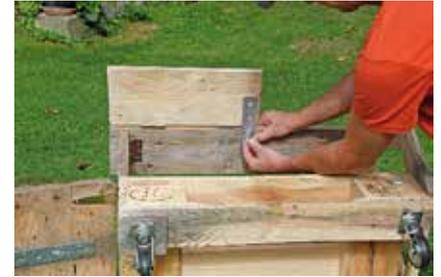
**24.** An der Unterseite der Armlehne einen Flachverbinder mit nur einer Schraube festmachen. So ist er beweglich und stabilisiert den Tisch im hochgeklappten Zustand.
