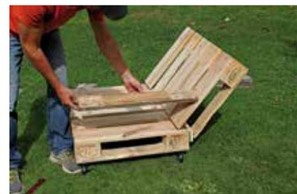
**15.** Die zweite Palette wird für Armlehnen, Kopf- und Fußstütze benutzt. Armlehne anhalten und abmessen. Vorsicht: Vorher mit der Zange Nägel entfernen.
