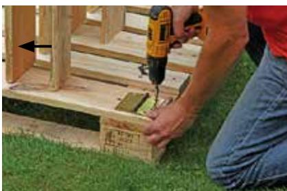
8. Die Scharniere erst am hinteren Sitzende mit Schrauben befestigen. Dann zu zweit die vordere Innenseite der Rücklehne (siehe Pfeil) mit dem Scharnier verbinden.
