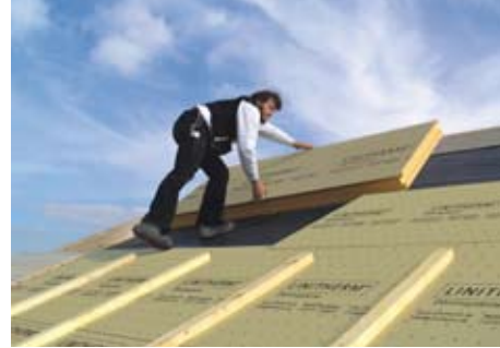
Mit einer Aufdachdämmung – ergänzend zur Dämmung zwischen den Dachsparren – kann ein hervorragender Wärmeschutz erzielt werden. Foto: Linzmeier
