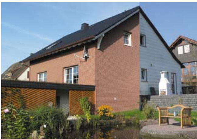
Die Sanierung zum förderfähigen Effizienzhaus erfordert einige Anstrengungen in puncto Dämmung und Heizungsmodernisierung. Rechts der Zustand vor der Fassaden-sanierung. (Foto: Klinker-Zentrale/epr)
