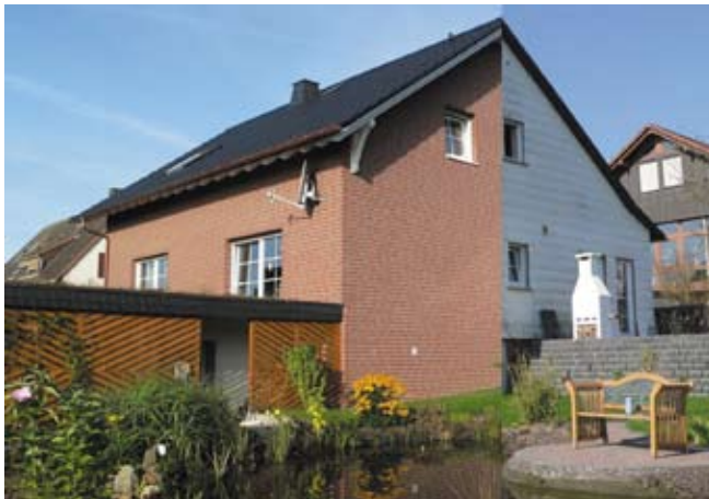
Die Sanierung zum förderfähigen Effizienzhaus erfordert einige Anstrengungen in puncto Dämmung und Heizungsmodernisierung. Rechts der Zustand vor der Fassaden-sanierung. (Foto: Klinker-Zentrale/epr)
