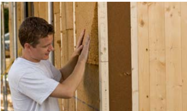
Dank der faserigen Struktur und der hohen Rohdichte leisten Holzfaserdämmstoffe guten Schallschutz. Foto: Steico
