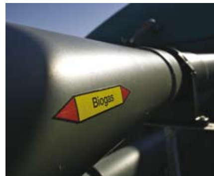
Biogas-Leitung als Teil einer Aufbereitungs- anlage.
