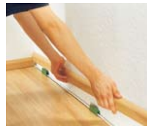
Fugen zwischen Laminat- oder Parkettboden und Wand verhindern die Trittschall-Übertragung auf die Wände und damit auf die Nachbarräume. Foto: Parador
