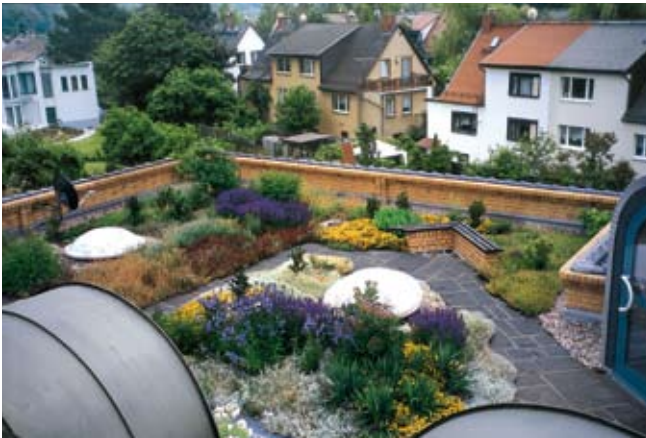
Dachgärten bringen für Hausbewohner ein deutliches Plus an Lebensqualität. Foto: DDV/ZinCo
