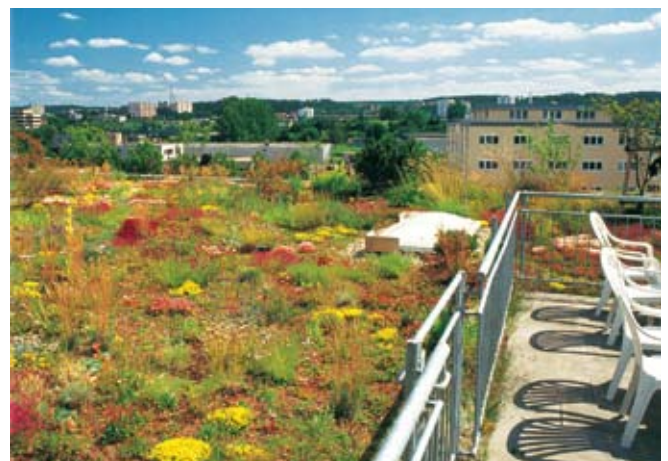
Auf extensiv begrüntem Dächern fühlen sich Spezialisten wie Mauerpfeffer, Fetthenne oder Heidenelke wohl, die gut mit Trockenheit zurechtkommen. Foto: ZinCo
