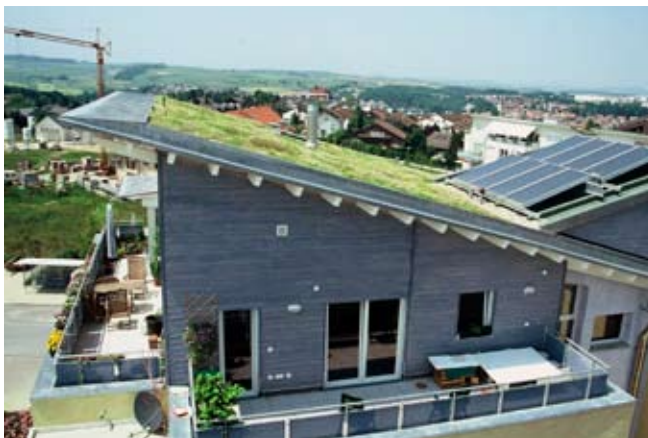
Bis zu Dachneigungen von 35 Grad sind Begrünungen möglich – je steiler, desto kostenaufwendiger. Foto: Optigrün
